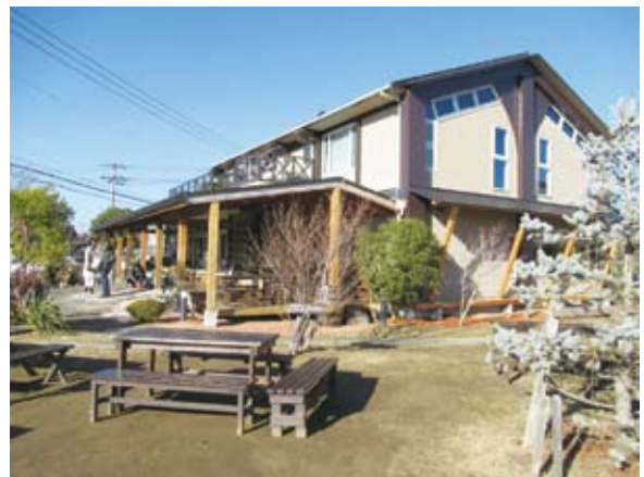
社屋裏側のレストランとカルチャースクールの入口
